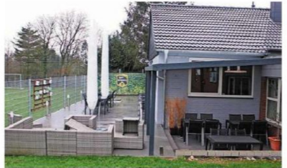
In Eigenregie erneuert: die Terrasse des Vereinsheims am Tannenweg.
